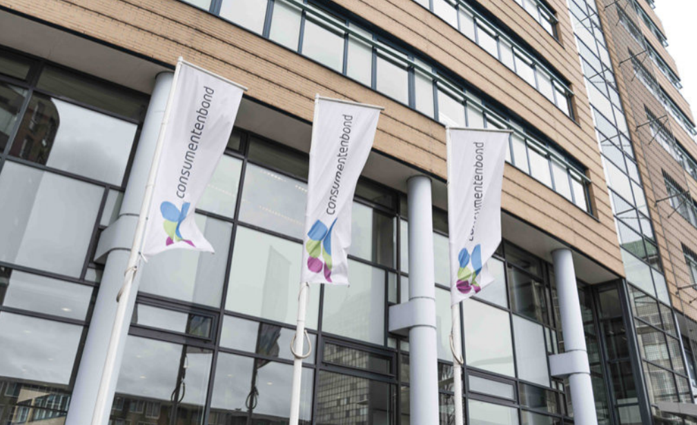
Het gebouw van de Consumentenbond in Den Haag
