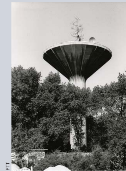
Aan de Belgische kust werden in Oost Duinkerke de signalen van de BBC ontvangen om vervolgens via straalverbindingen naar Nederlandse (en Belgische) kabelnetten te worden verstuurd.
