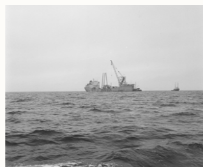
REM-tv eiland op Noordzee, in aanbouw voor de kust van Noordwijk
